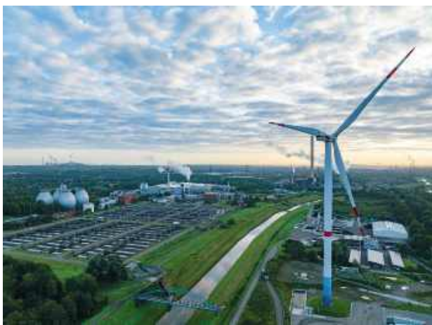
Luftbild der Kläranlage Bottrop (links)
