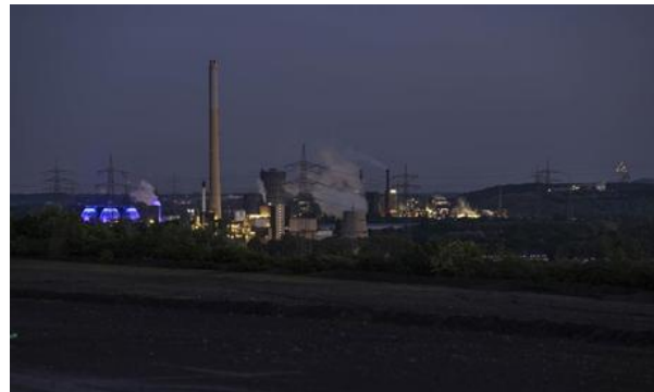
Die Kläranlage Bottrop bei Nacht, Foto: EGLV
