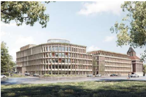
Bauteil A Foto: EGLV
