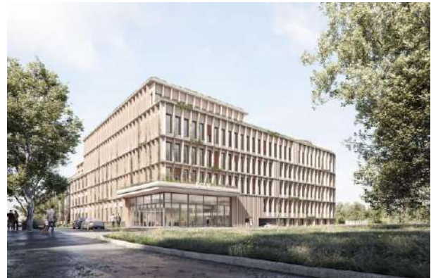
Vorderansicht vom Neubau Foto: EGLV
