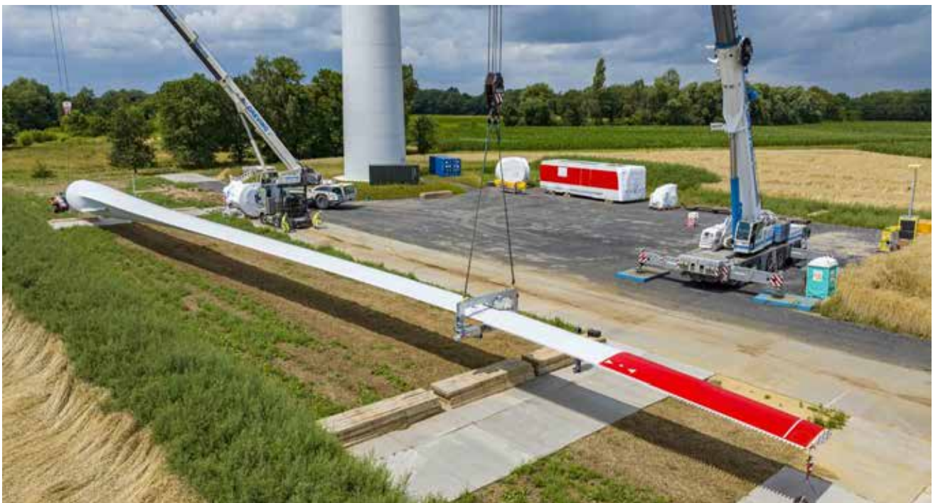
Für ein Windrad der BETREM werden im Windpark Große Heide in Dorsten drei Flügel abgeladen. Flügelänge 65 Meter, Gewicht 22,3 Tonnen. Foto: Andreas Fritsche/EGLV
