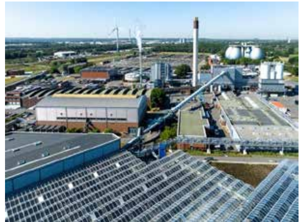
Luftbild der Kläranlage Bottrop Blick über die Kläranlage, im Vordergrund die solare Schlamm-trocknung, im Hintergrund die Faulbehälter und das Windrad Foto: Detlef Macher/EGLV
