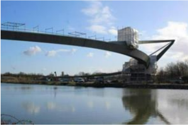
Die Brücke über dem Rhein-Herne-Kanal, mit Blick auf einen Stahlzügel. Foto: Leonie Matthes/EGLV
