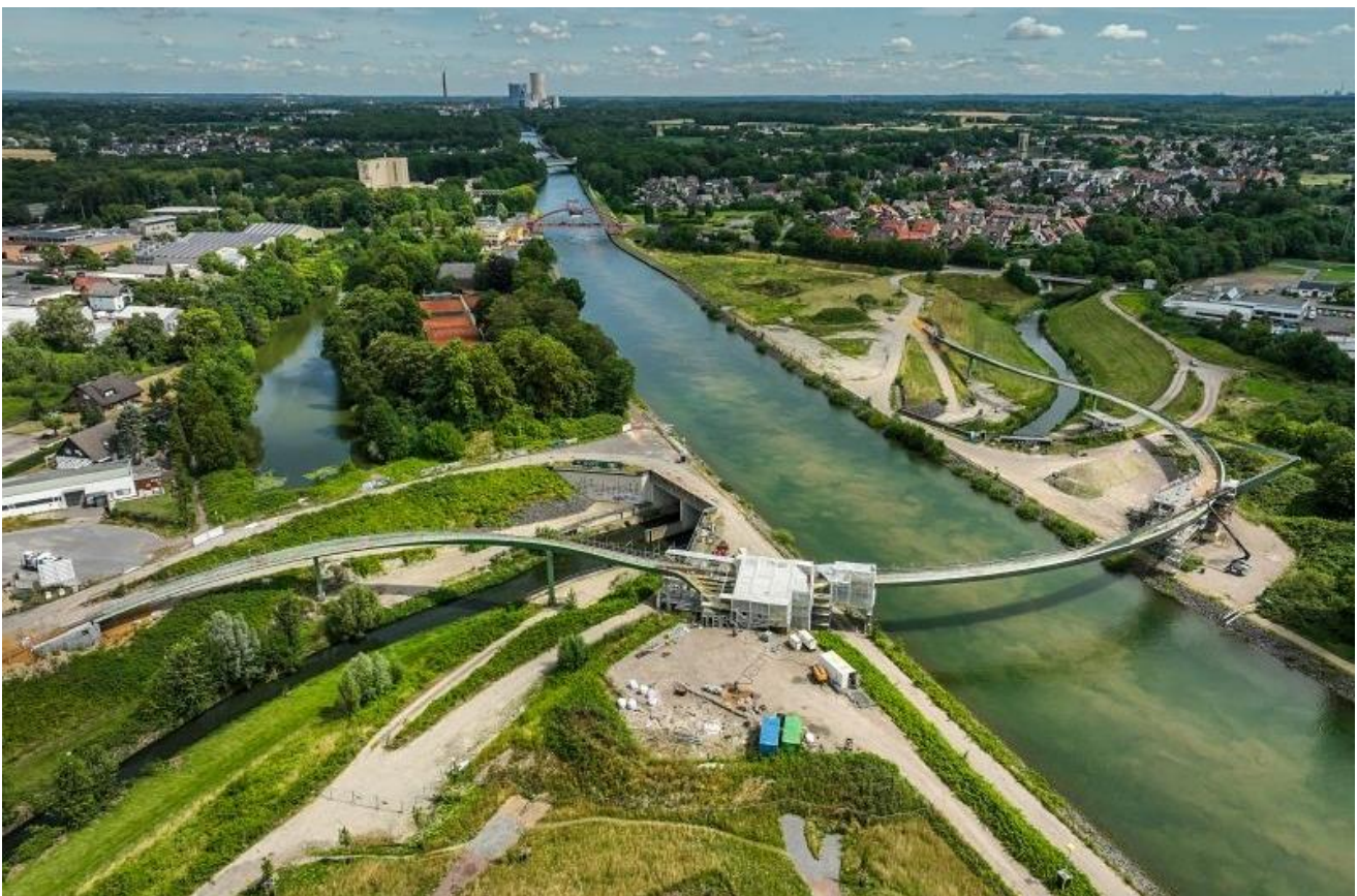
Aktuelles Luftbild der Brücke „Sprung über die Emscher“, Stand: 18.07.2023 Foto: Rupert Oberhäuser/EGLV
